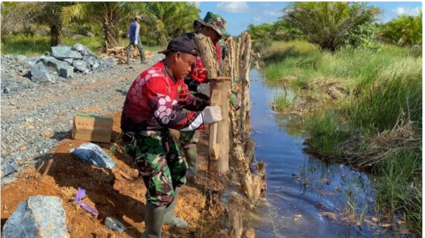
"Kayu Galam" Potensial Untuk Landasan Pemasangan Pondasi
