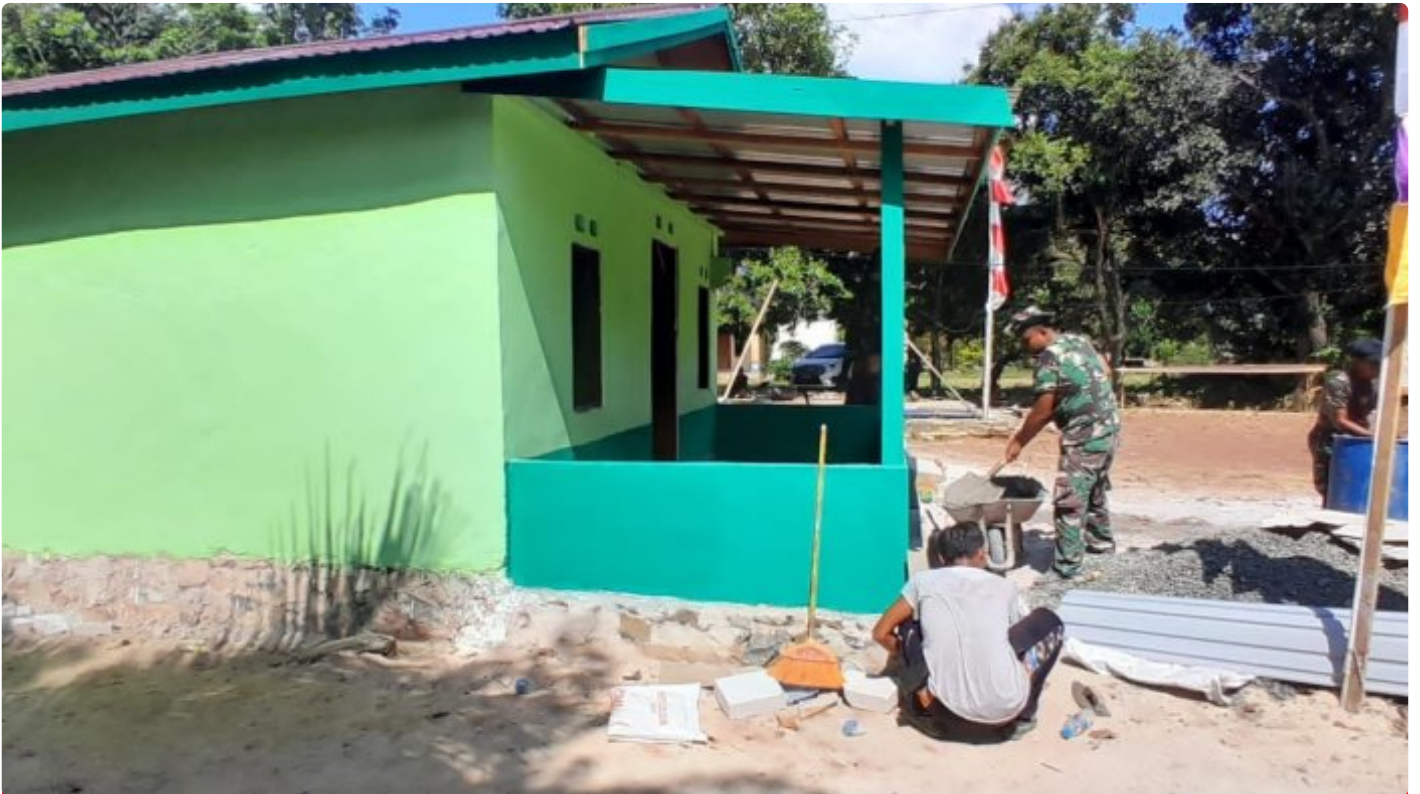
Pengerjaan Rumah Mbah Sandi Hampir Rampung
