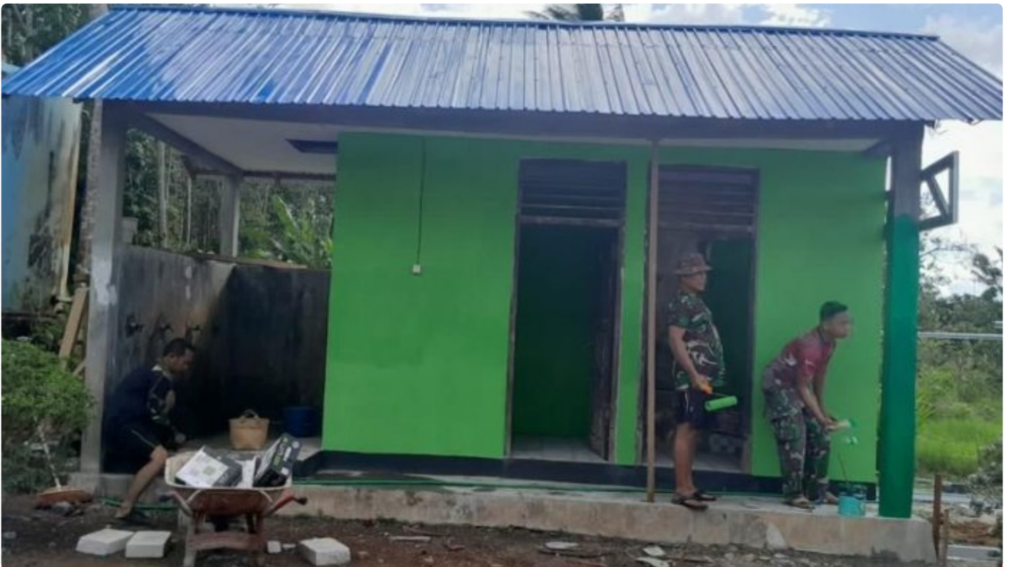
Pengerjaan Sasaran Rehab Masjid, Tinggal Finising
