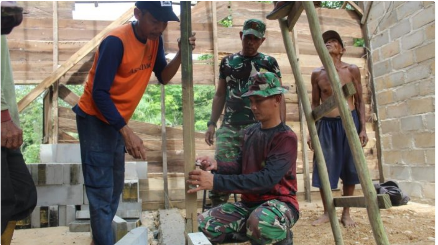
Sasaran Bedah Rumah, Sudah Tahap Pemasangan Dinding
